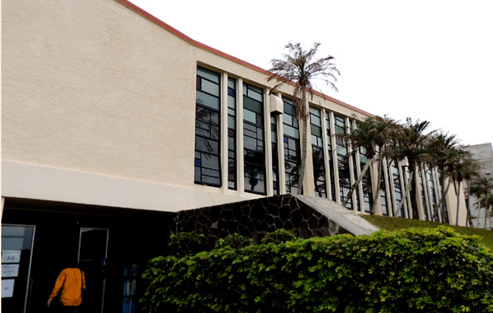
▲受付が設置された正面入口より中へ
